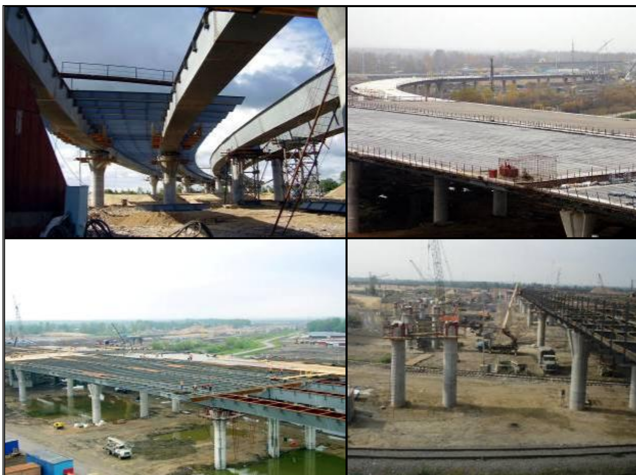
Рис. 1. Строительство Западного Скоростного Диаметра
